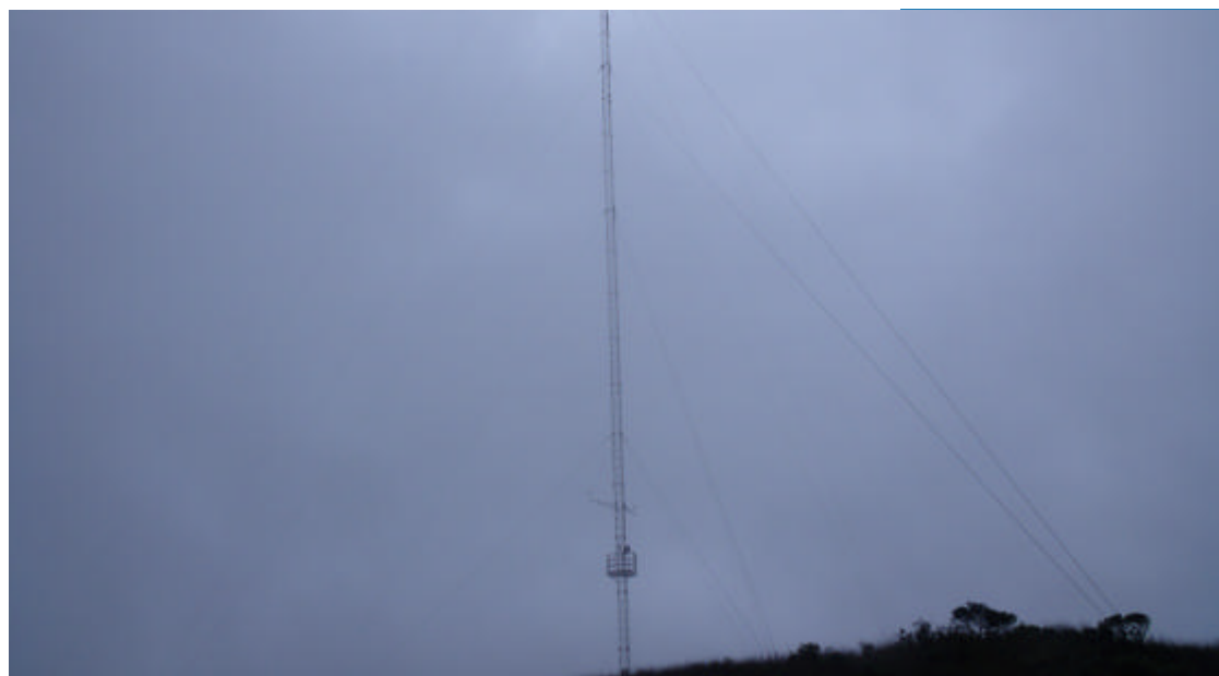
过白马山后第一个风力测试塔
